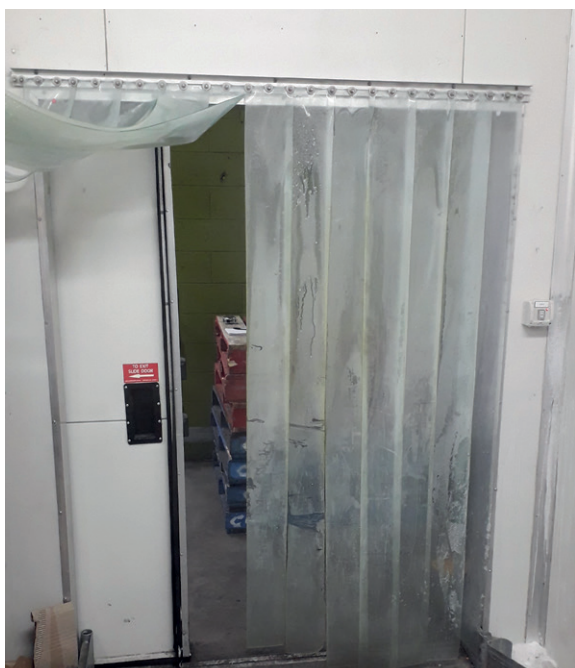
Lameller hængt til side af medarbejdere, så der ikke er nogen termisk barriere
