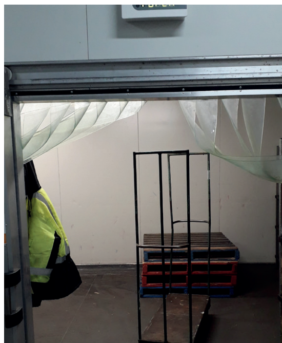
Lameller hængt til side af medarbejdere, så der ikke er nogen termisk barriere
